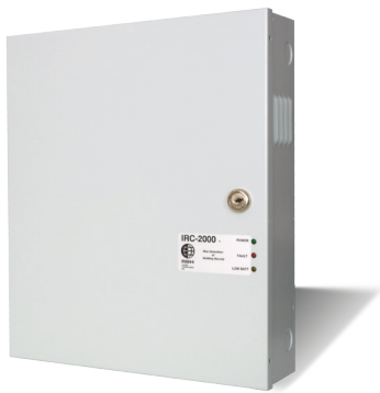
Incluant contrôleur IRC-2000... boîtier, bloc d'alimentation 2 lecteurs proximité FR360, logiciel 64 portes.
